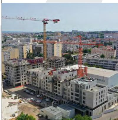
En partenariat avec Lafarge Holcim, cet ouvrage a également permis de tester des bétons « très bas carbone » dont l'empreinte carbone est inférieure de 90% à celle d'un béton classique. Cette formule a été utilisée pour la réalisation de quelques voiles béton. Une qualité de parement soignée a été obtenue, qui atteste du potentiel de développement de ces matériaux innovants.
