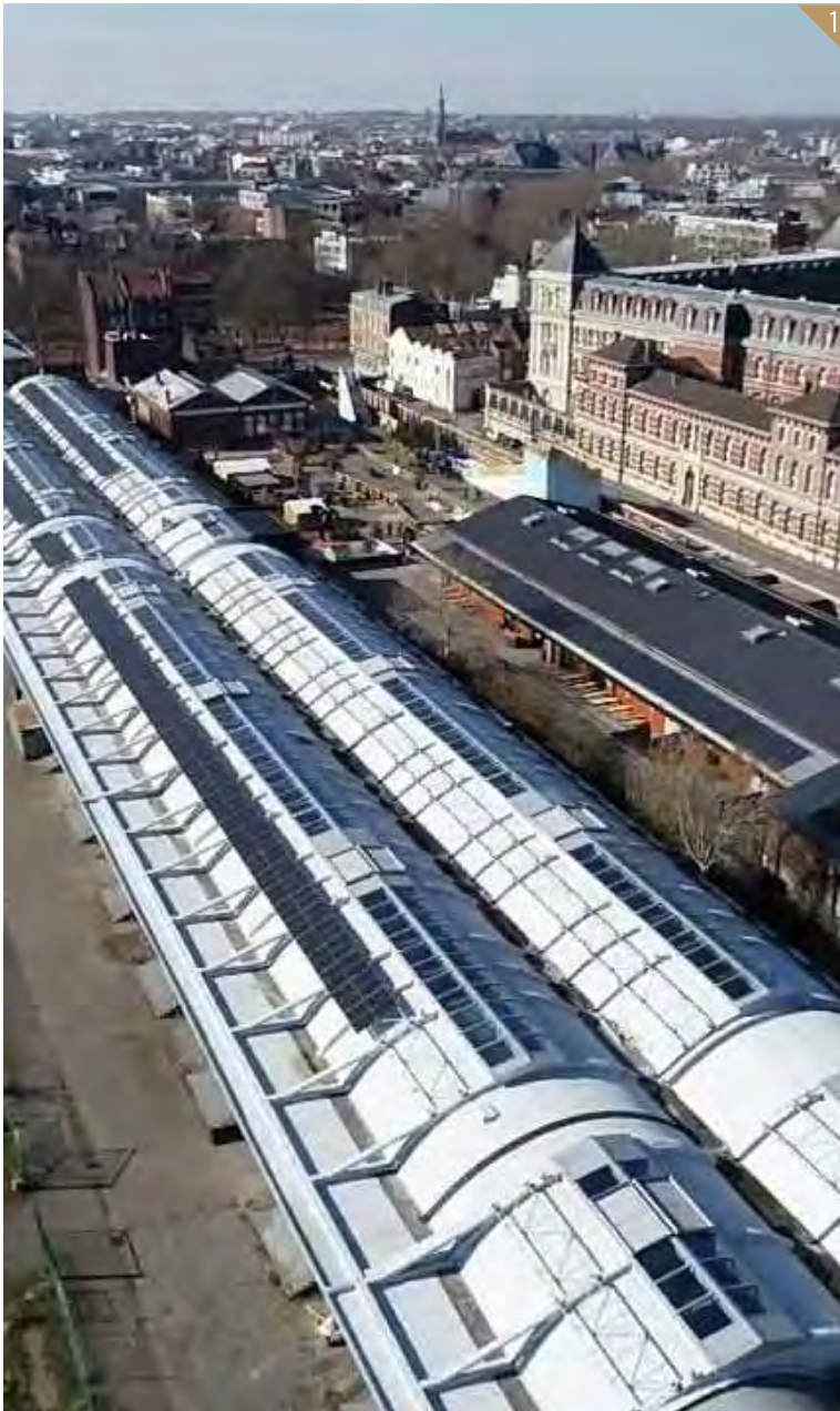
1. GARE SAINT-SAUVEUR METROPLE DE LILLE - FRANCE
