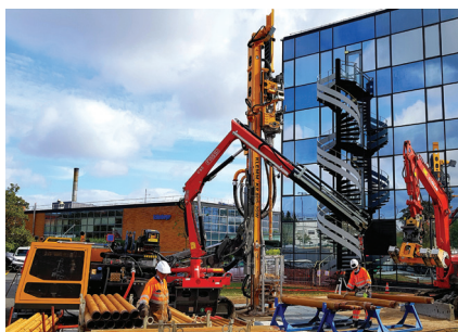
Le chantier de forage.
