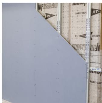
L'isolant est inséré entre les montants. Le pare-vapeur, obligatoire, sera positionné directement sur l'isolant ou sur l'ossature métallique.
