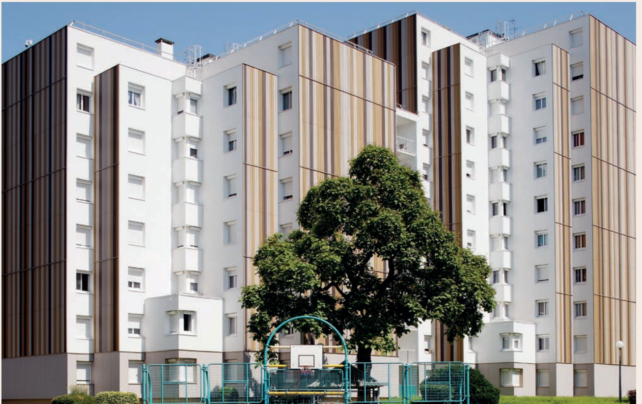
Logement collectif - Maisons Alfort (94) - COVER 6 & 14 - Teintes Sand & Sun & Earth • Architecte : Nicolas Fritz / Ville de Maisons Alfort
