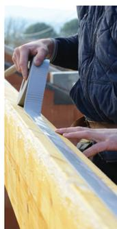
**Descriptif :** Bande de mousse PVC à cellules fermées avec adhésif acrylique de haute qualité, largeur 5 cm et épaisseur 4,5 mm.
