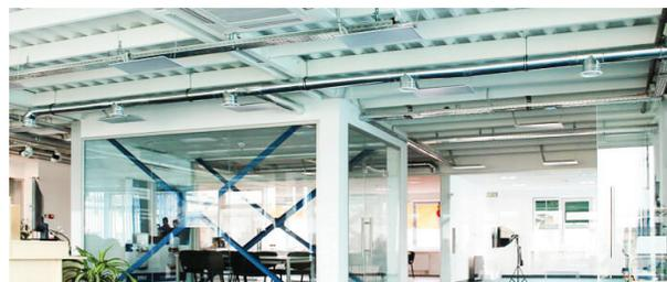
Les modules de ventilation de la série industrielle, conçus pour une utilisation intérieure, sont installés à l'aide de supports et de colliers, fixés à la surface d'appui.
