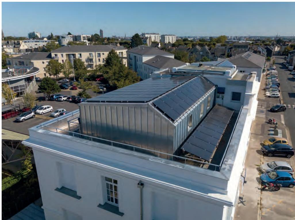
► Pose de panneaux solaires hybrides DualSun et de panneaux solaires pour la production d'eau chaude et d'électricité lors de la rénovation de l'immeuble « La Marseillaise » à Nantes.
